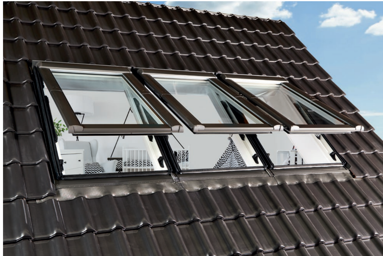
Kombi-Eindeckrahmen 3x1 mit Koppelsparren und 120 mm Abstand
